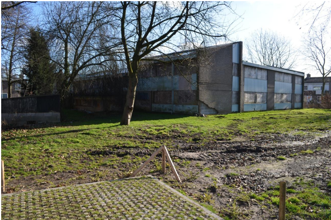
Zicht op de noord westhoek van het WBC gebouw
